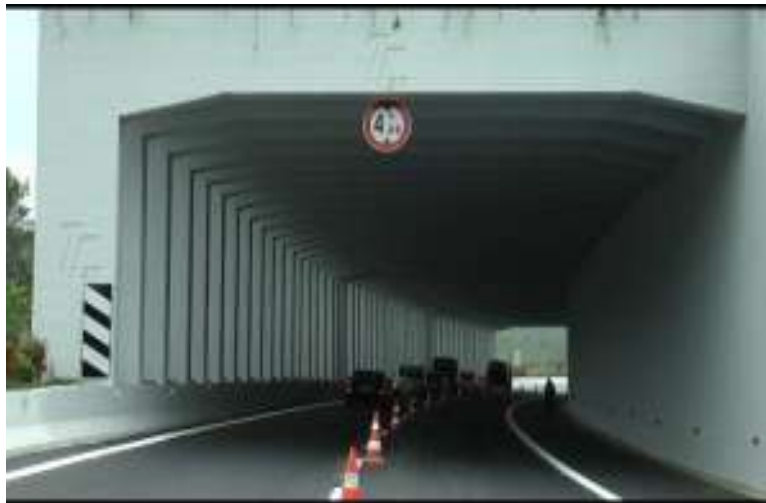
Figura 2-11 Tuneli për stabilizimin e shpatit (Monitor.al, 2019)
