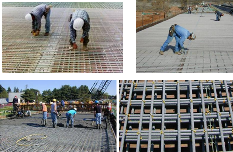
Figura 2.6. Urë prej betoni të përforcuar me FRP, Morriskoën – Vermont (USA) [2002]
