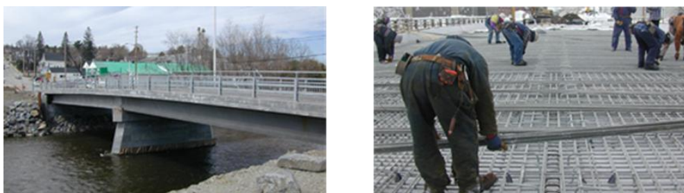
Figura 2.7. Urë prej betoni të përforcuar me GFRP, Cookshire-Eaton-Quebec [2003]
