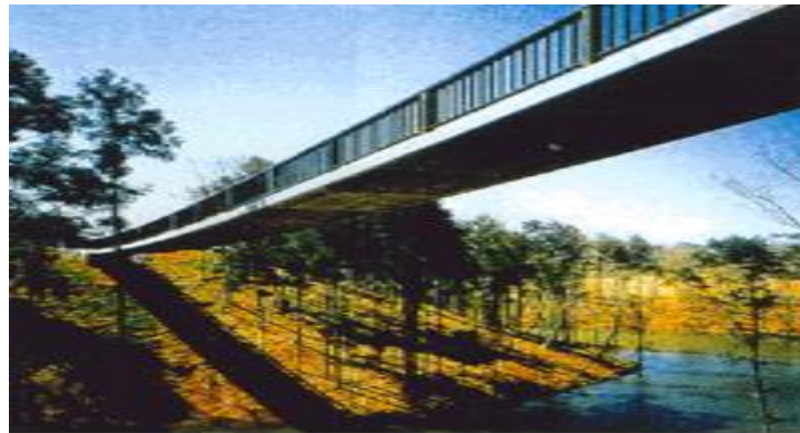
Figura 2.4. Përdorimi i shufrave CFRP të parandëruara në një urë në Klubin Country Yard, Japoni
