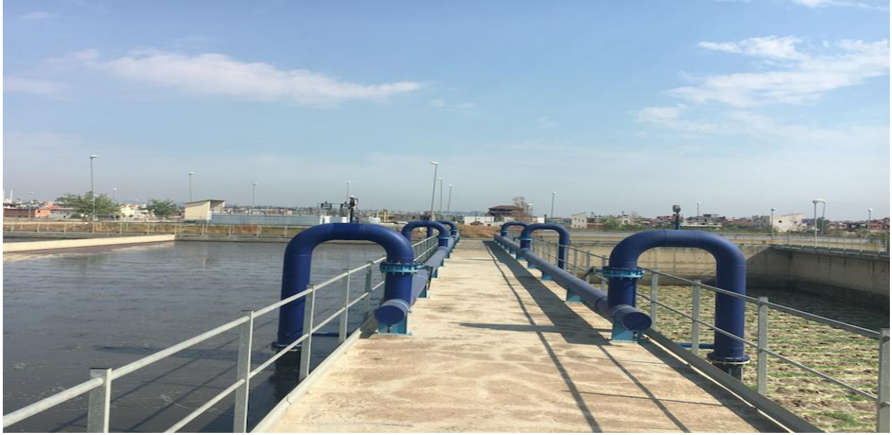
Figura 5 Pamje nga rezervuari i ajrimit që është në funksion
